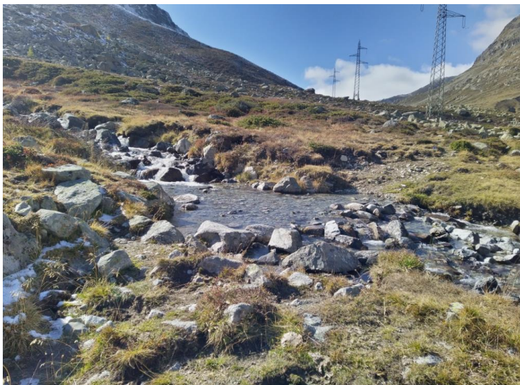
Abbildung 31: Foto zeigt den Bereich wo eine Brücke gebaut wird
