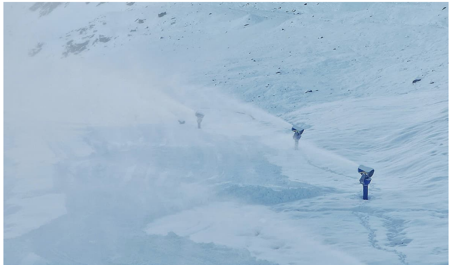
Beschneiungsanlagen im Skigebiet Corvatsch, Quelle: Bergbahnen Corvatsch
