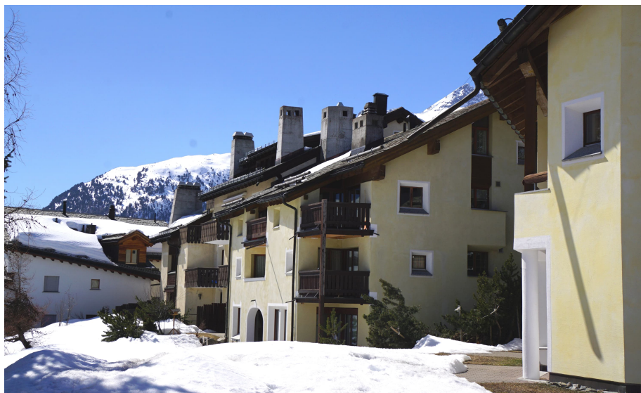
Ortsübliche Bauweise in der Gemeinde Silvaplana
